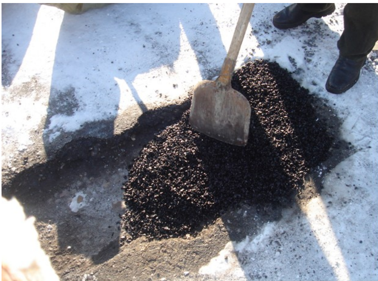
Рисунок 11.2 – Укладка холодной ремонтной смеси в выбоину (декабрь, 2011 г.)
