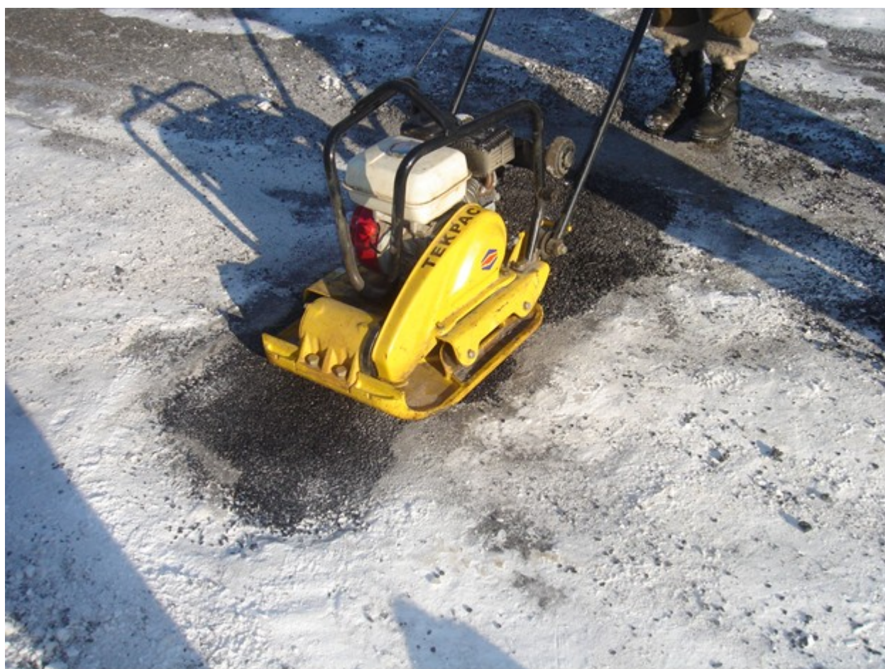
Рисунок 11.3 – Уплотнение холодной ремонтной смеси вибротрамбовкой
