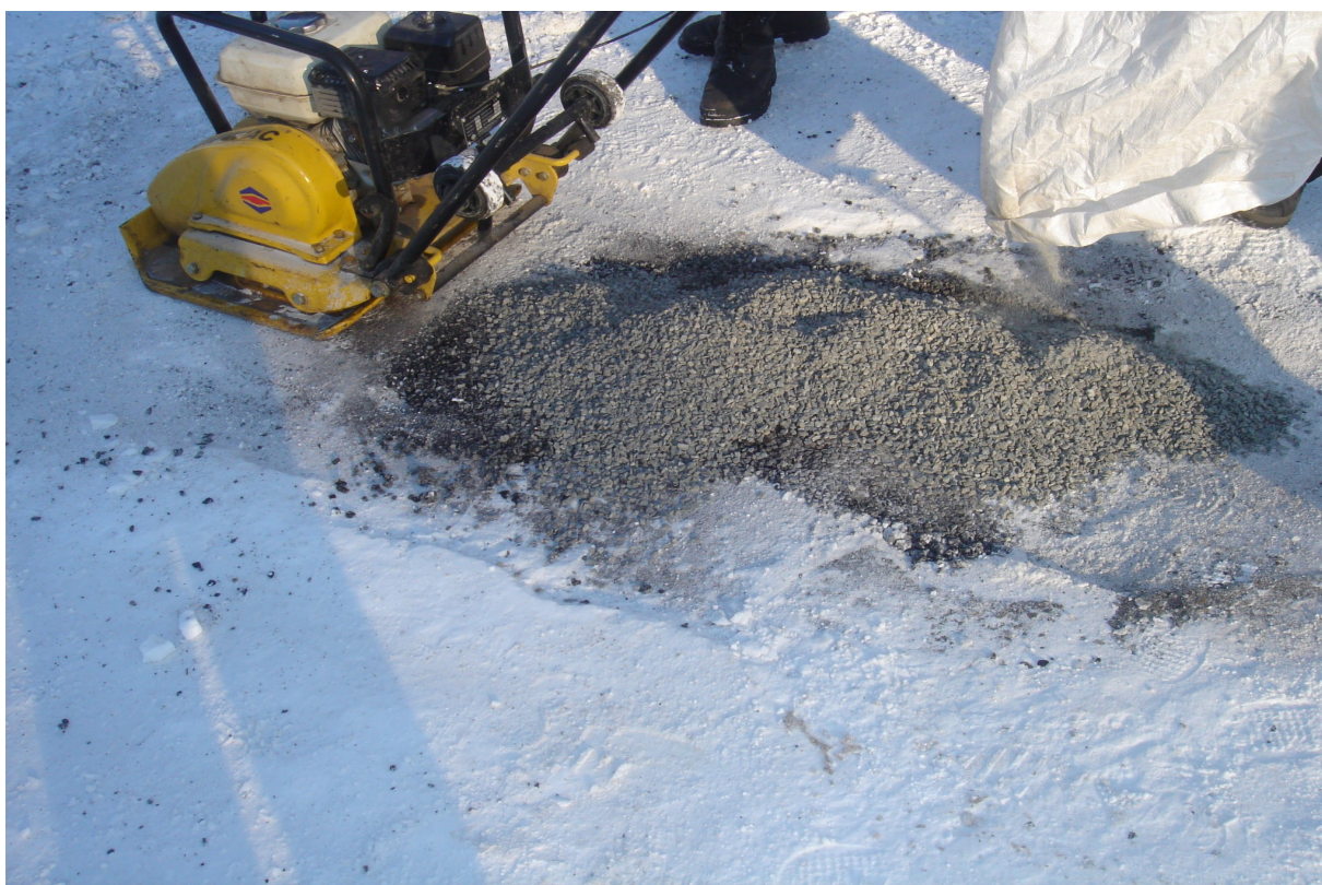
Рисунок 11.4 – Посыпка отремонтированного участка выбоины белым щебнем и повторное уплотнение
